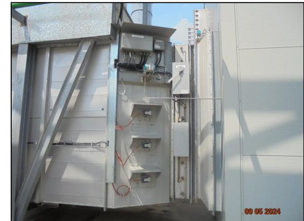
รูปที่ 2.27 ระบบป้องกันการรั่วซึมของก๊าซ (Gas Detector บริเวณ Gas Turbine)
