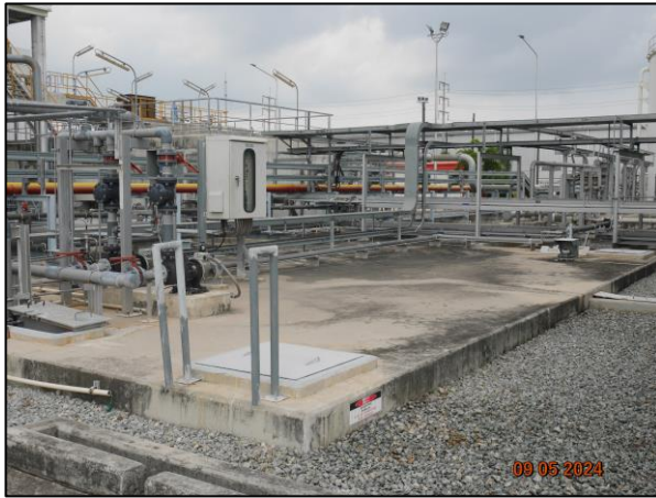
รูปที่ 2.15 ป่อปรับสภาพความเป็นกรด-ด่าง (Neutralization Pit)
