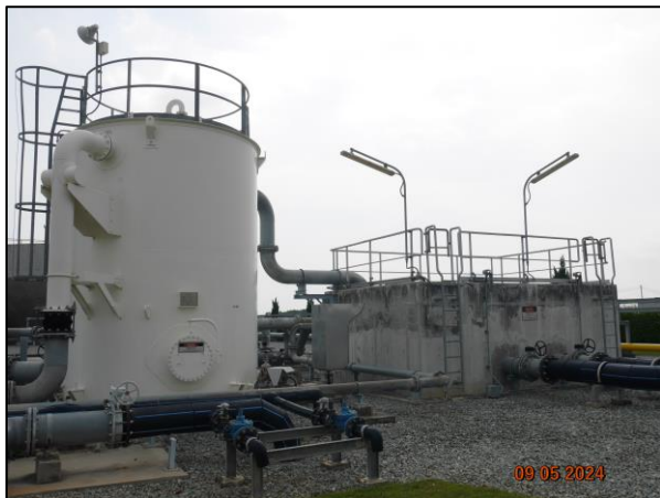
รูปที่ 2.12 ป่อตรวจสอบคุณภาพน้ำทิ้ง
