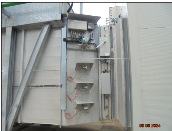
รูปที่ 2.27 ระบบป้องกันการรั่วซึมของก๊าซ (Gas Detector บริเวณ Gas Turbine) (ต่อ)
