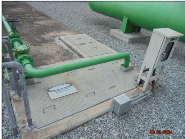
รูปที่ 2.17 ป่อแยกน้ำมัน (Oil Separator)
