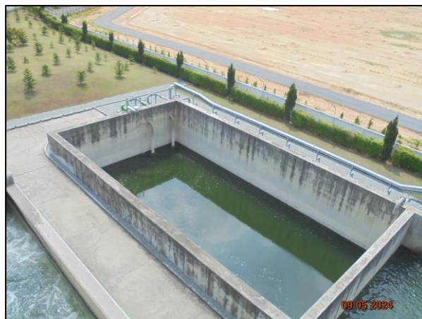
รูปที่ 2.14 ป่อพักน้ำทิ้งฉุกเฉิน (Emergency Pit)
